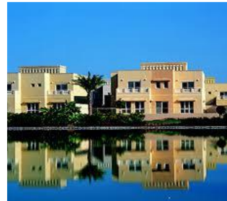
Project: Medous Villas- Dubai MEP Contractor: ETA MNE -DUBAI
