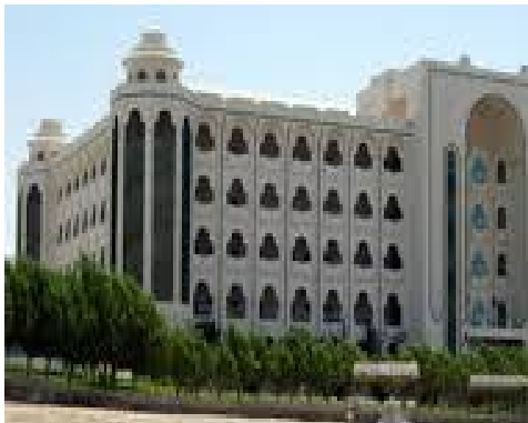
Project: Ghantoot Palace-Abudhabi MEP Contractor: ETA M&E
