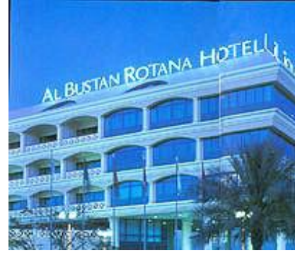
Project: Al Bustan Rotana Hotel-Dubai MEP Contractor: ETA MNE
